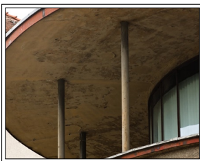
Aufnahme 2009 • Foto, P.Wießenthaner
